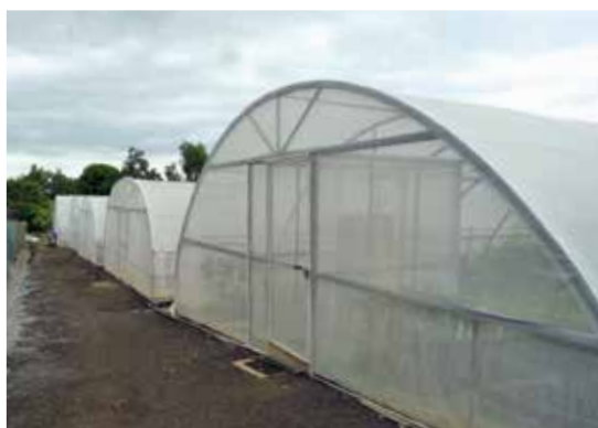
Blocs d'amplification chez les pépiniéristes - Photos IT2
